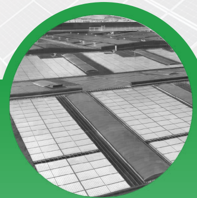
Estructura en Cubierta
