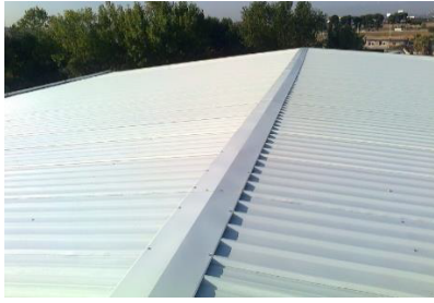
CUBIERTA INCLINADA (UN AGUA O DOS AGUAS)
