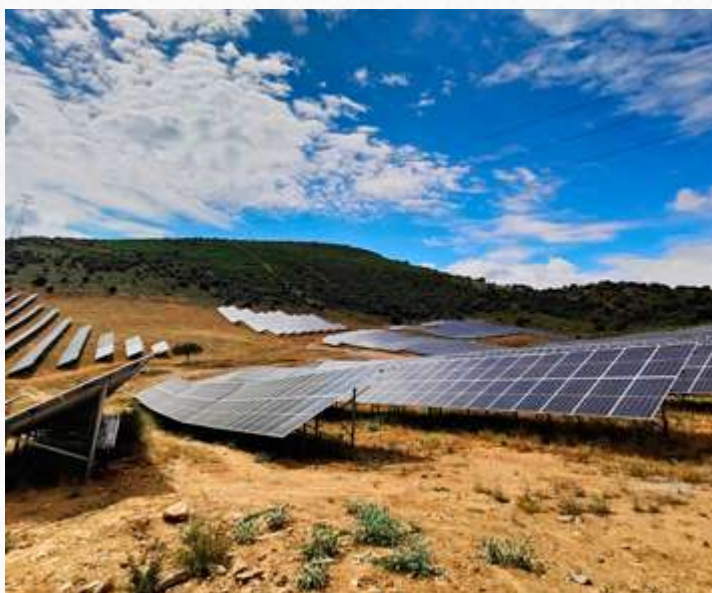
Estructura Hincada 2V Biposte
