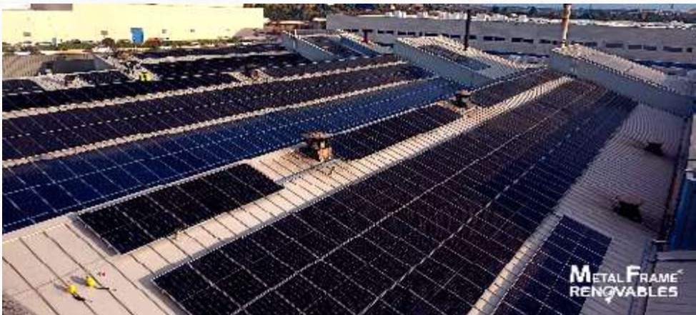
Estructura Coplanar anclaje a Greca
