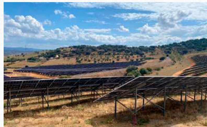
Estructura Hincada 2V Biposte
