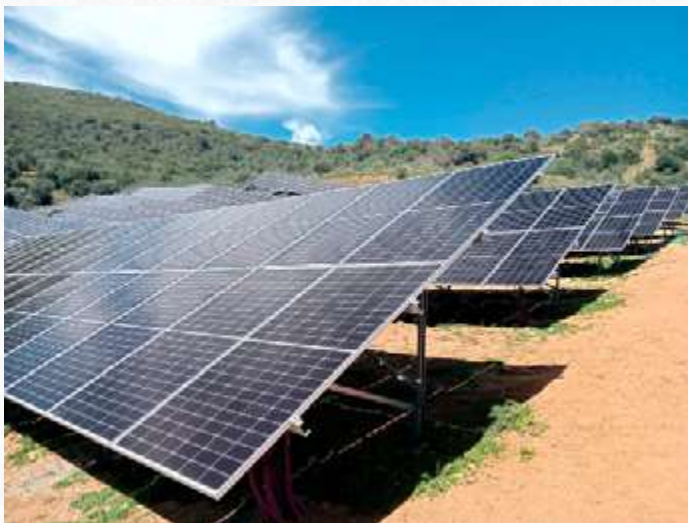
Estructura Hincada 2V Biposte
