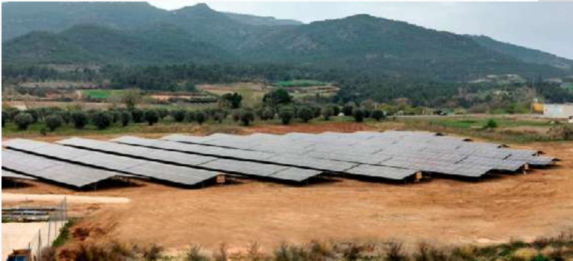
Estructura Este-Oeste sobre Suelo
