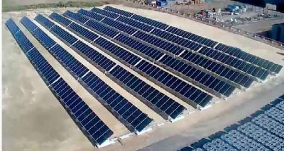
Estructura IV Lastrada en Terreno
