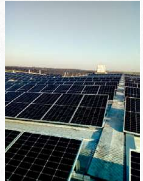
Estructura 1V en Cubierta y fijación a correa
