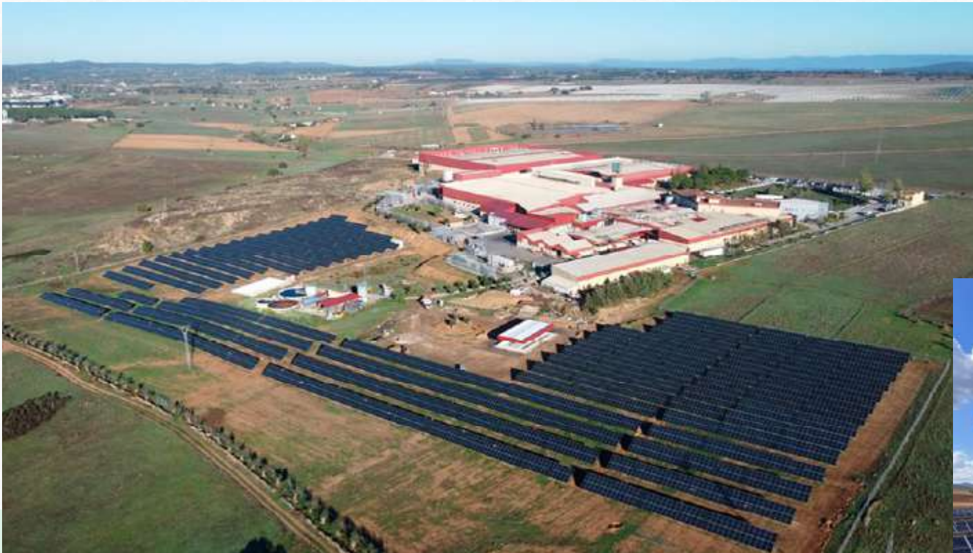
Estructura Hincada 2V Biposte
