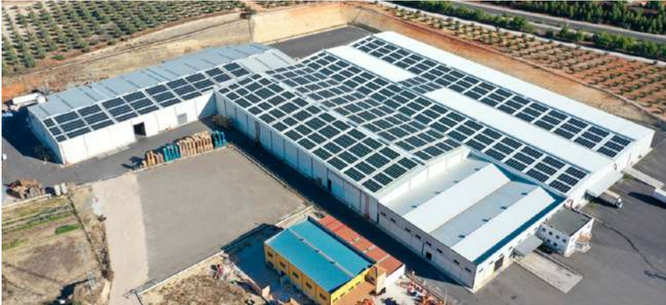
Estructura Coplanar por Tramos
