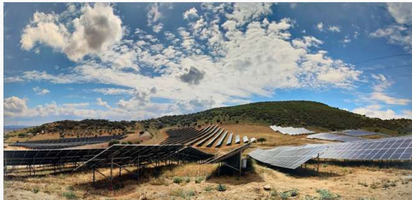
Estructura Hincada 2V Biposte
