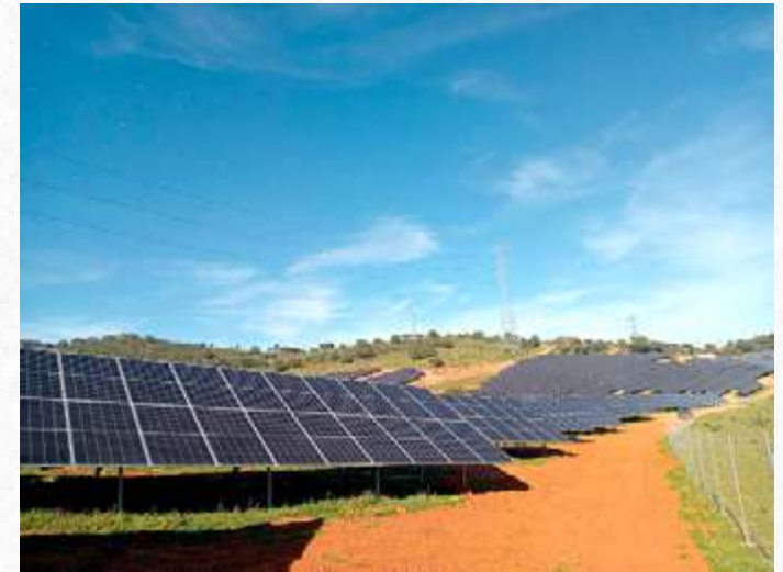
Estructura Hincada 2V Biposte
