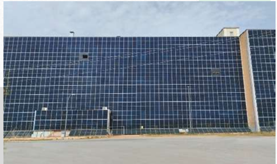
Estructura Coplanar en Fachada
