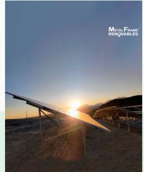
Estructura Hincada 2V Biposte
