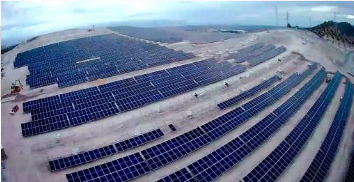
Estructura Hincada 2V Biposte
