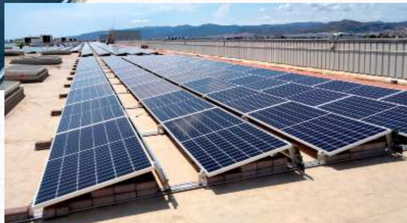
Estructura SICA (Solución Autoportante Inclinada 10°)
