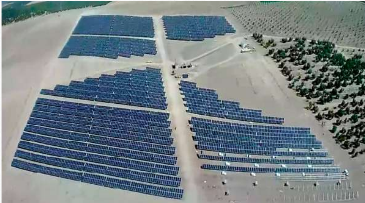
Estructura Hincada 2V Biposte
