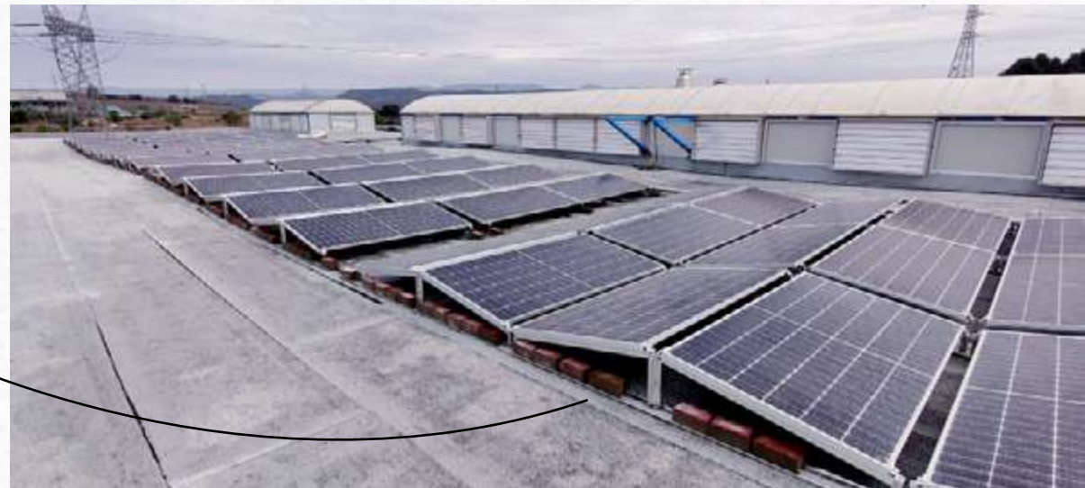
Estructura Este-Oeste sobre Cubierta
