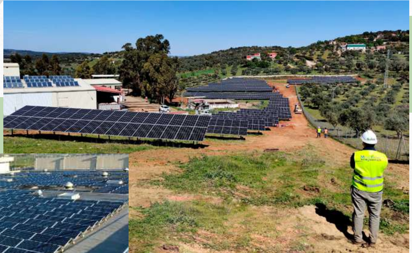
Estructura Hincada 2V Biposte
