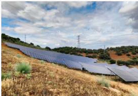
Estructura Hincada 2V Biposte
