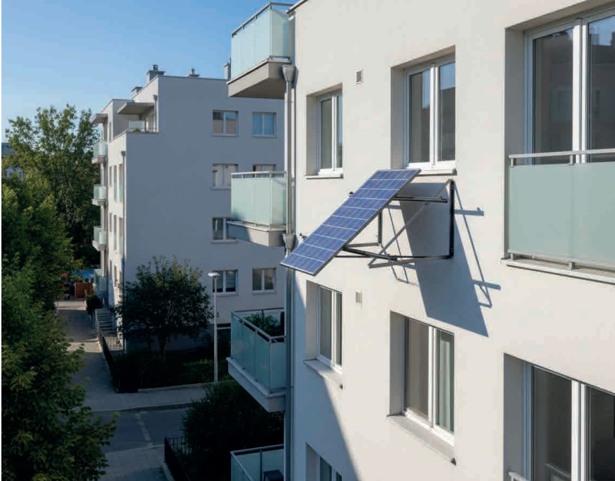
Sistema de fijación intermedia de módulos FV
